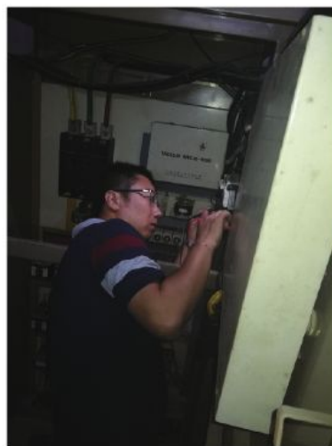
维修消防水泵控制柜
