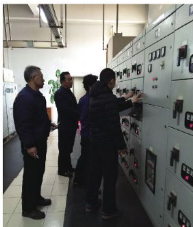
变电站设备检修
