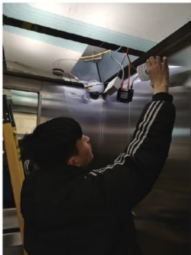
电梯摄像头修理
