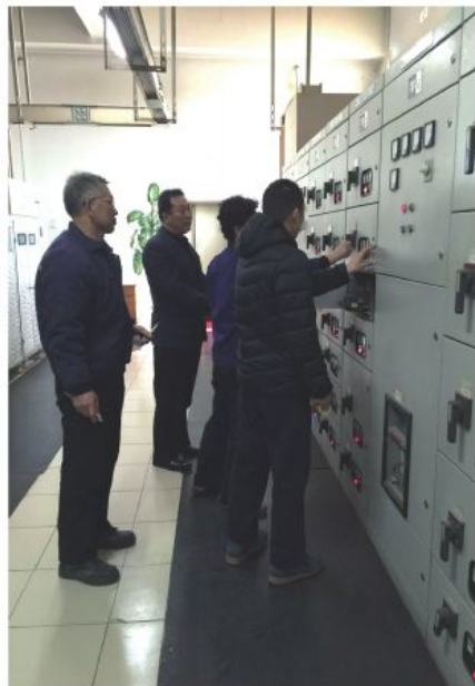
变电站设备检修
