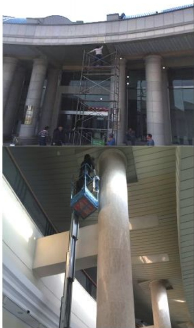
馆舍内外墙大理石维护
